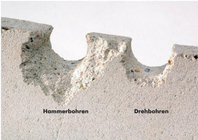
Bild 5.29: Einfluss des Bohrverfahrens auf die Bohrlochgeometrie in einem Kalksandlochstein
