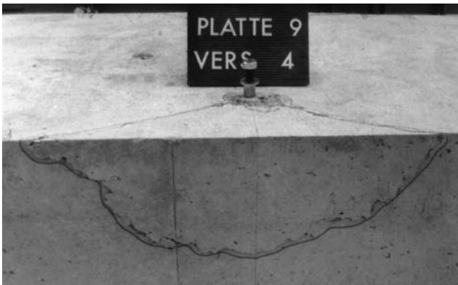
Bild 5.14: Betonbruch eines randnahen Dübels unter Querbeanspruchung zum Rand [9]
