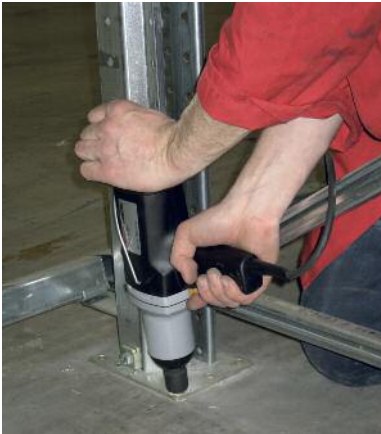
Bild 5.18: Montage eines Schraubankers mit einem Schlagschrauber [10]
